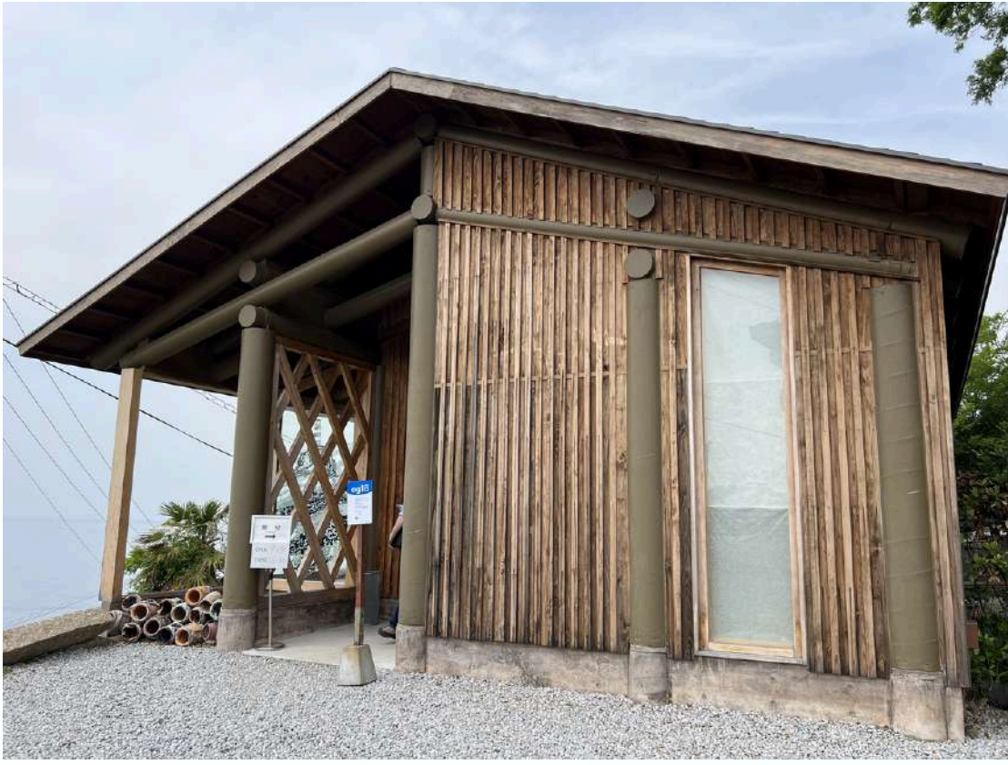
建物外観。外に面した柱もすべてリサイクル紙管。特殊な設計・処理により十分な強度を誇る
